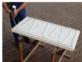
Montage mit PU-Klebschaum
