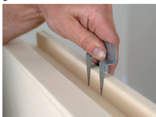
Befestigung mit Befestigungsklammern
