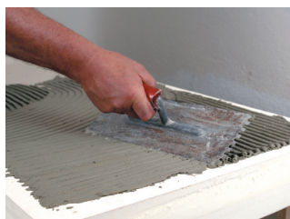
Befestigung mit Flexkleber
