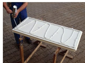
Montage mit PU - Klebeschaum
